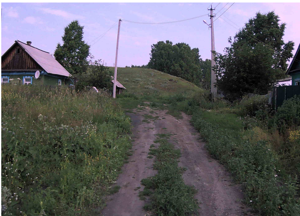
Рисунок 2.4.5 – Состояние покрытия на участке ПК 0+105
