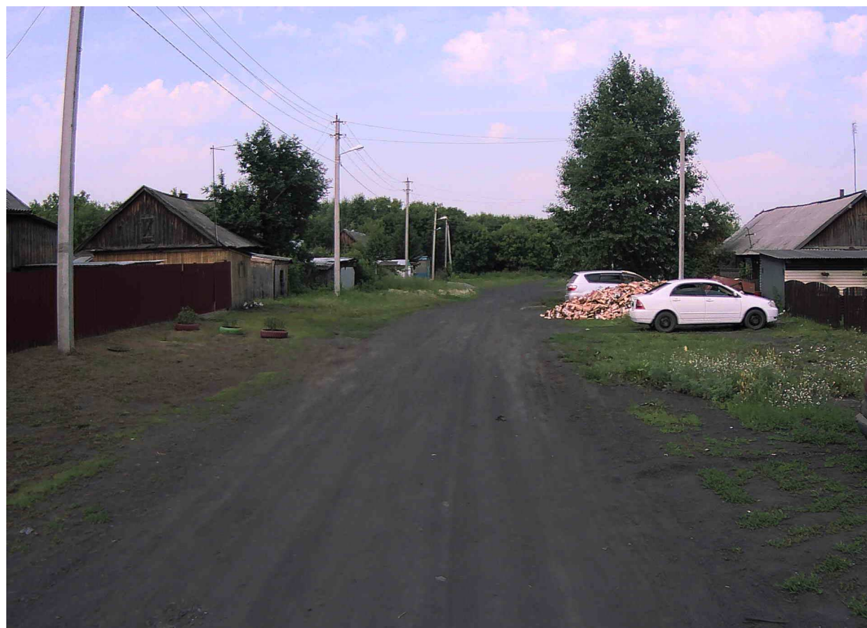
Рисунок 2.21.5 – Состояние покрытия на участке ПК 0+190
