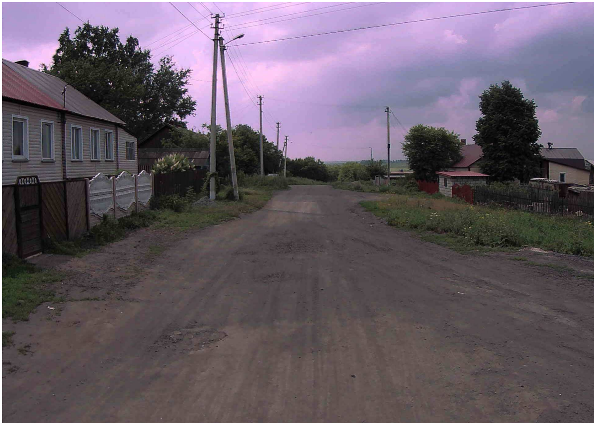
Рисунок 2.22.6 – Состояние покрытия на участке ПК 0+280
