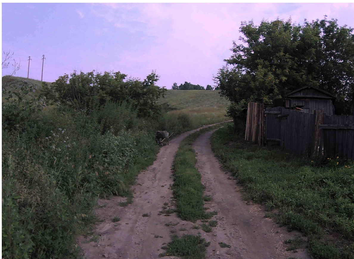
Рисунок 2.7.5 – Состояние покрытия на участке ПК 0+140
