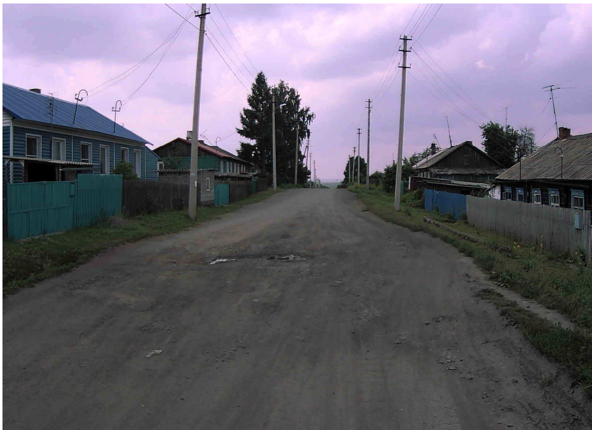
Рисунок 2.22.4 – Состояние покрытия на участке ПК 0+040
