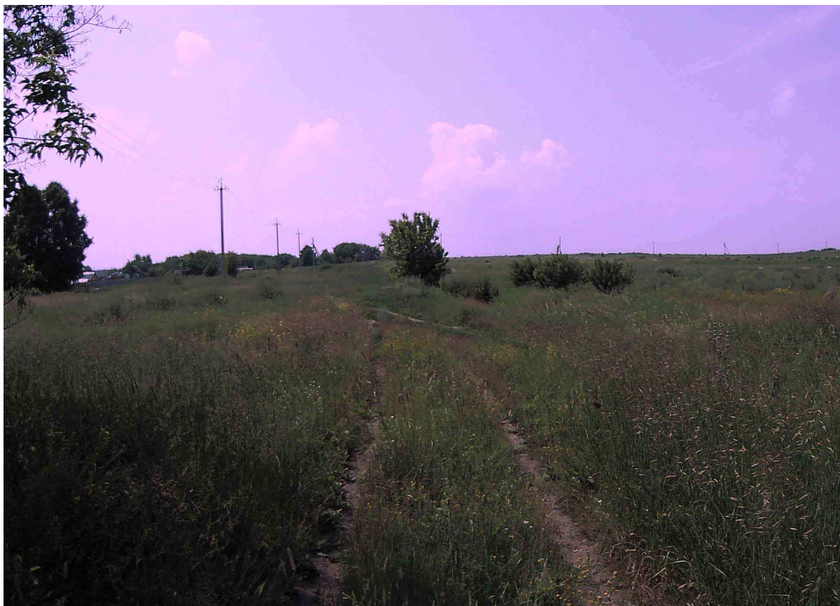
Рисунок 2.16.4 – Состояние покрытия на участке ПК 0+090
