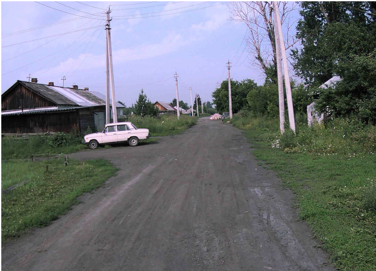
Рисунок 2.19.4 – Состояние покрытия на участке ПК 0+080
