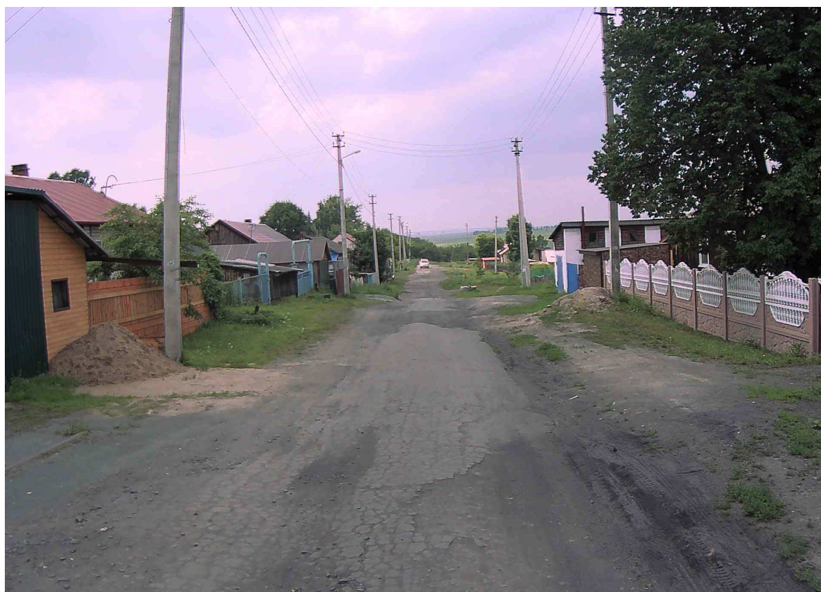
Рисунок 2.22.5– Состояние покрытия на участке ПК 0+180
