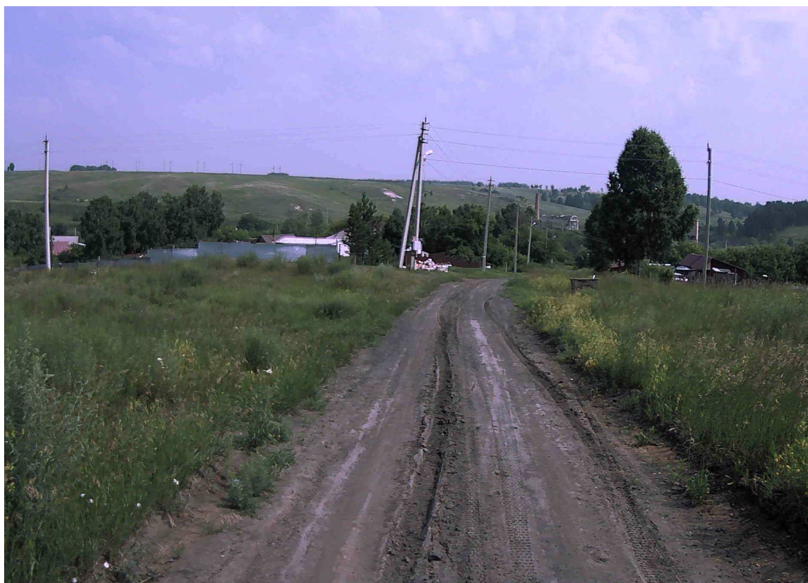
Рисунок 2.11.5 – Состояние покрытия на участке ПК 0+315
