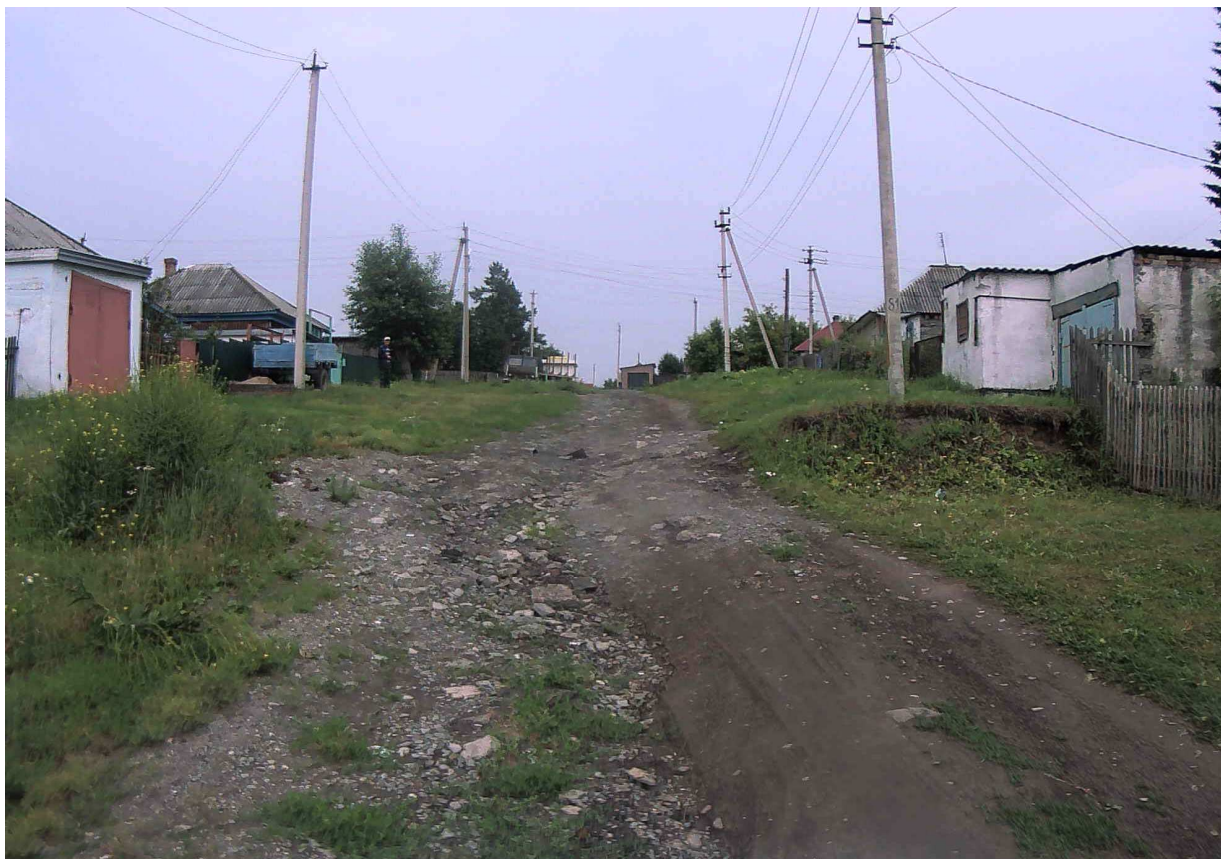
Рисунок 2.18.4 – Состояние покрытия на участке ПК 0+090
