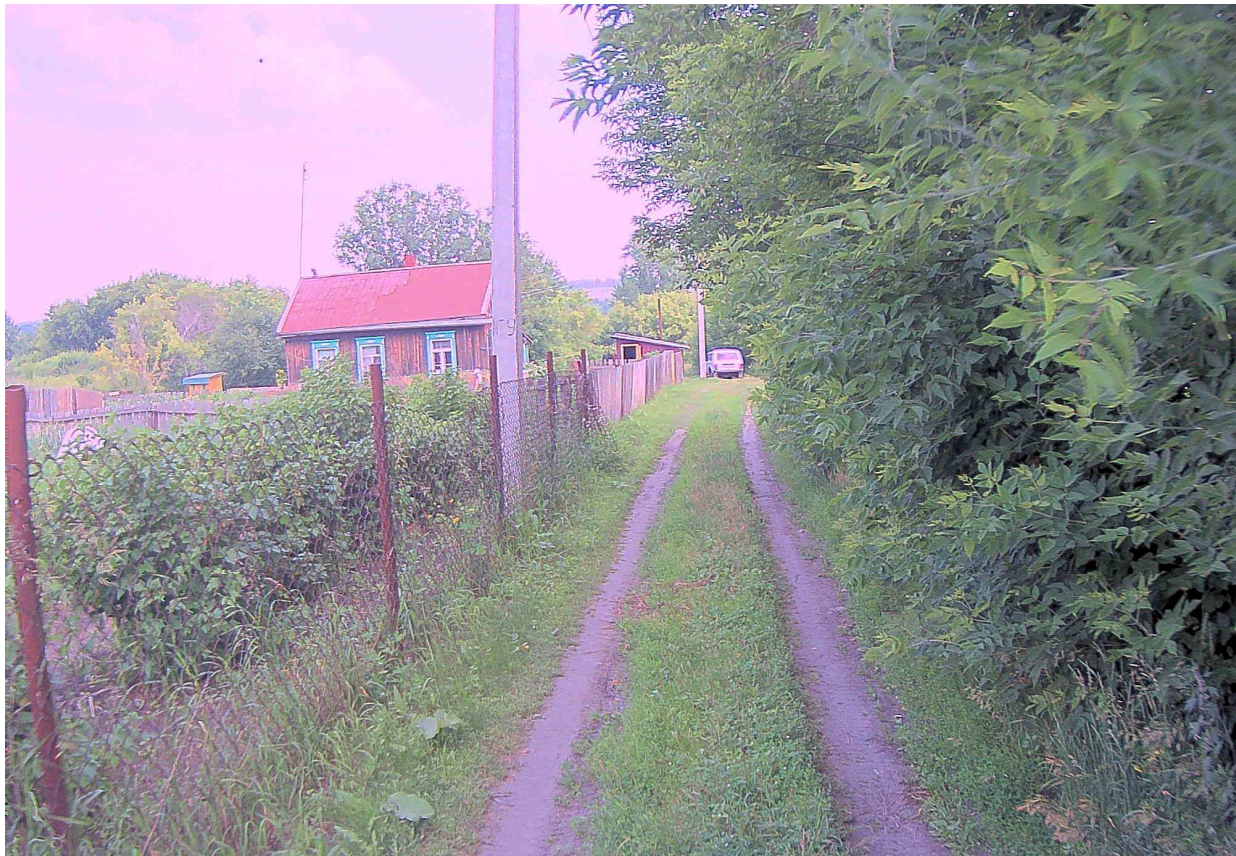
Рисунок 2.2.4 – Состояние покрытия на участке ПК 0+035
