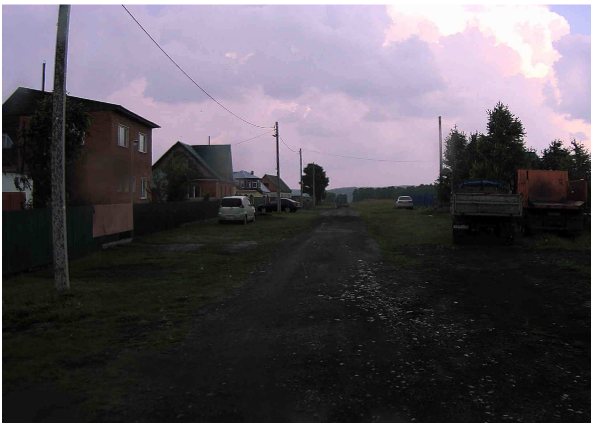
Рисунок 2.13.7 – Состояние покрытия на участке ПК 0+800
