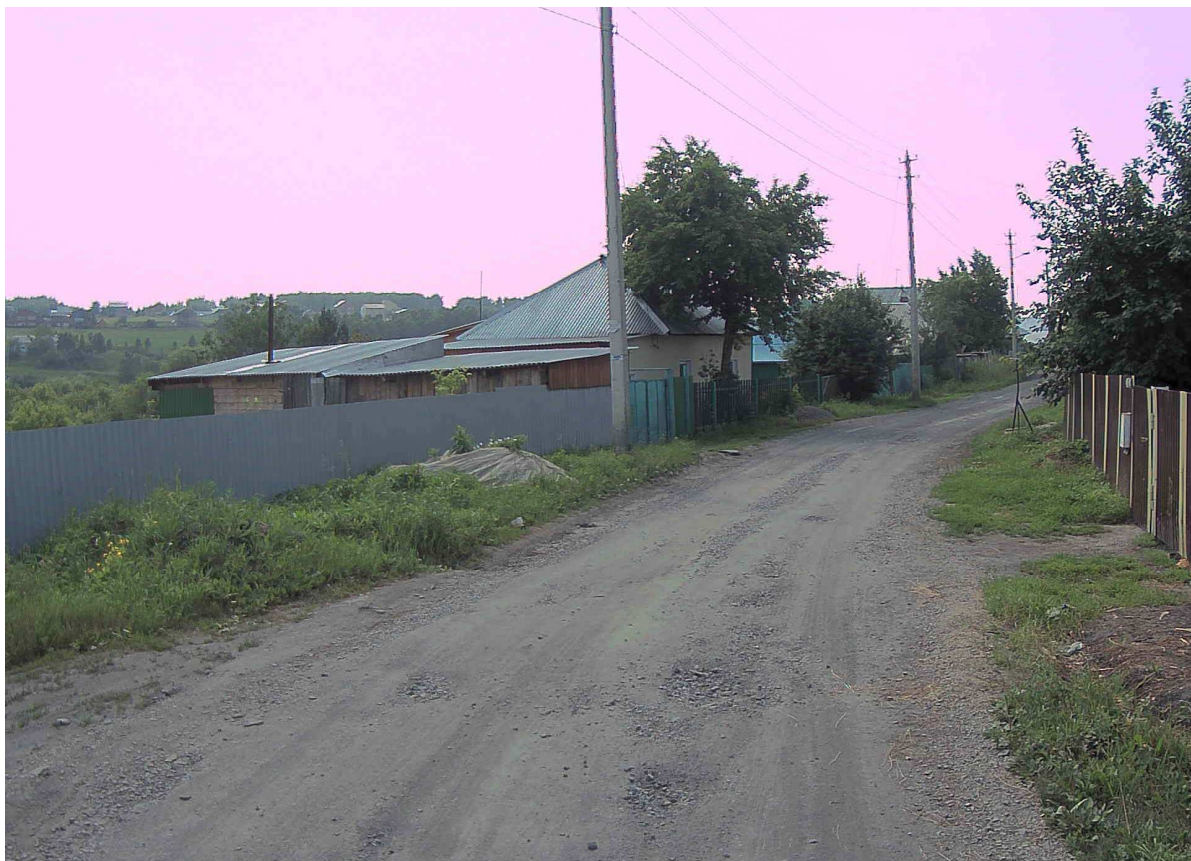
Рисунок 2.10.4 – Состояние покрытия на участке ПК 0+115
