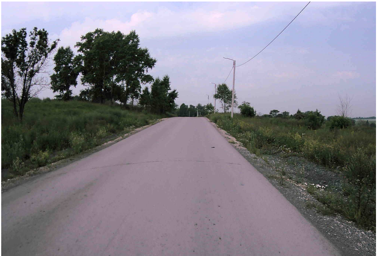
Рисунок 2.17.7– Состояние покрытия на участке ПК 0+530
