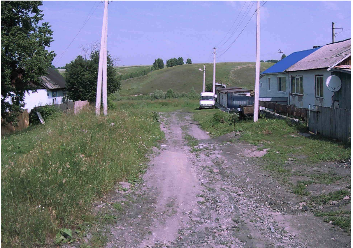
Рисунок 2.14.6 – Состояние покрытия на участке ПК 0+325
