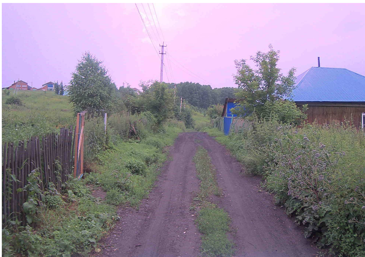
Рисунок 2.20.5 – Состояние покрытия на участке ПК 0+220
