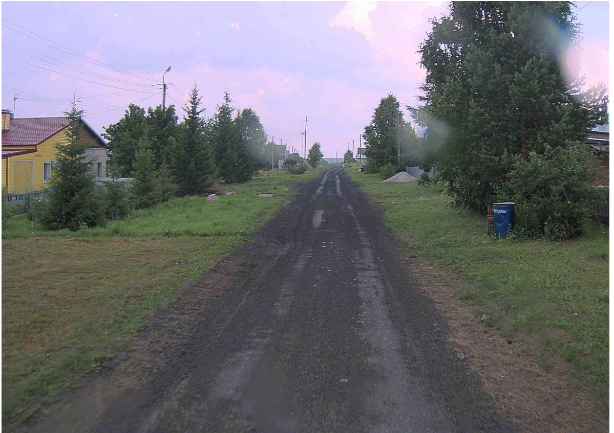
Рисунок 2.13.4 – Состояние покрытия на участке ПК 0+200
