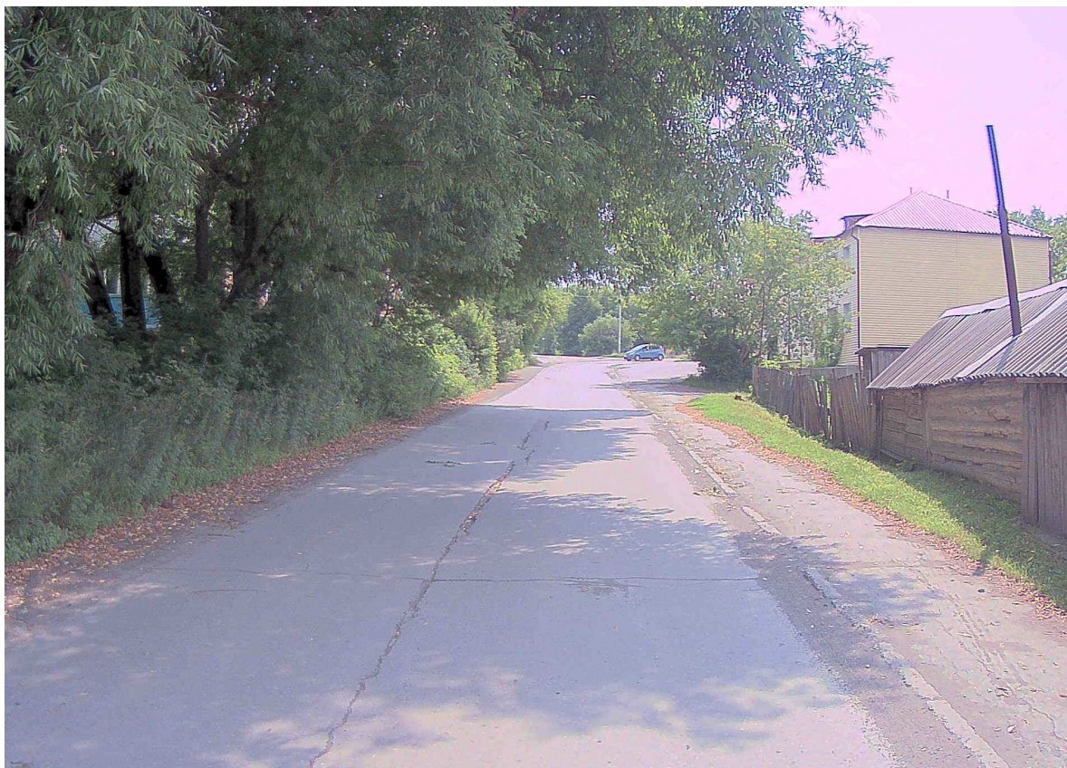
Рисунок 2.24.6 – Состояние покрытия на участке ПК 0+090
