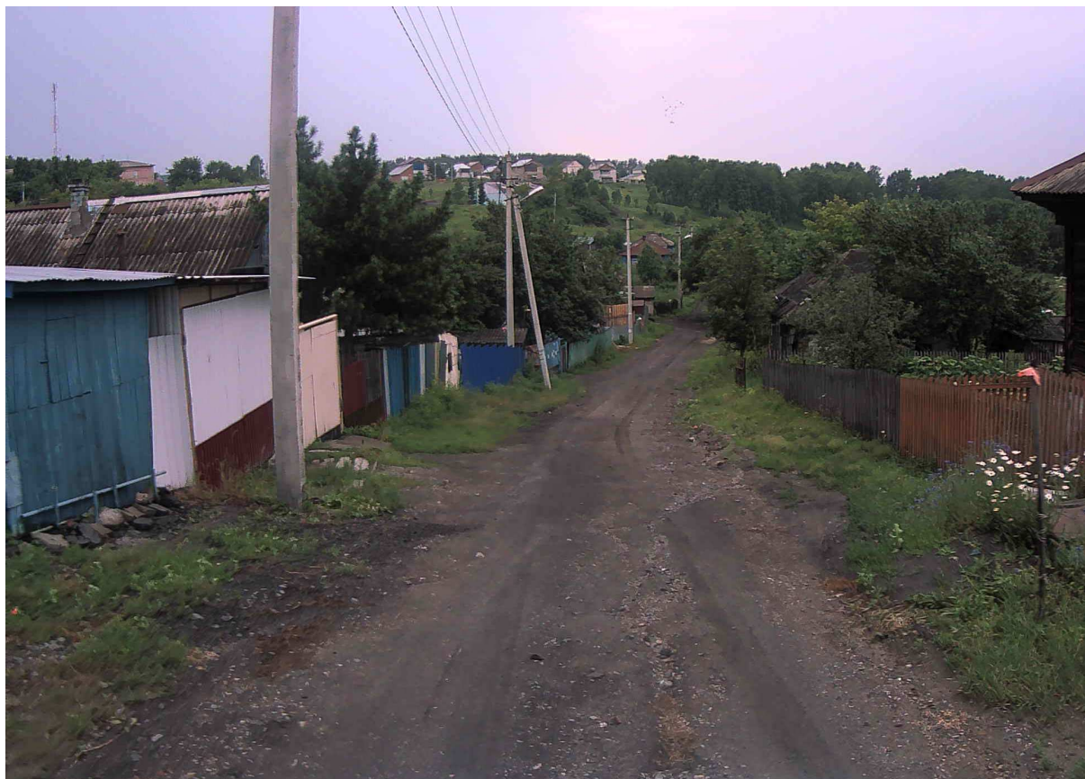
Рисунок 2.20.4 – Состояние покрытия на участке ПК 0+120
