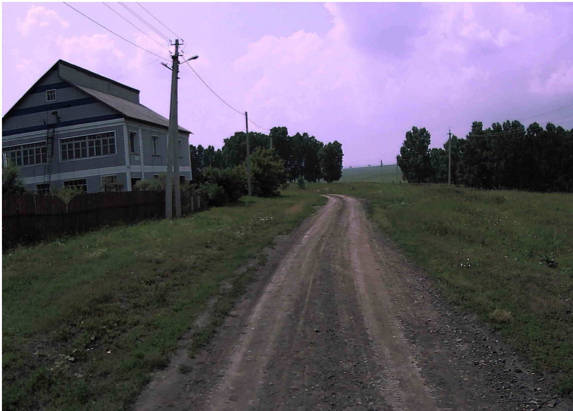
Рисунок 2.24.10 – Состояние покрытия на участке ПК 0+930
