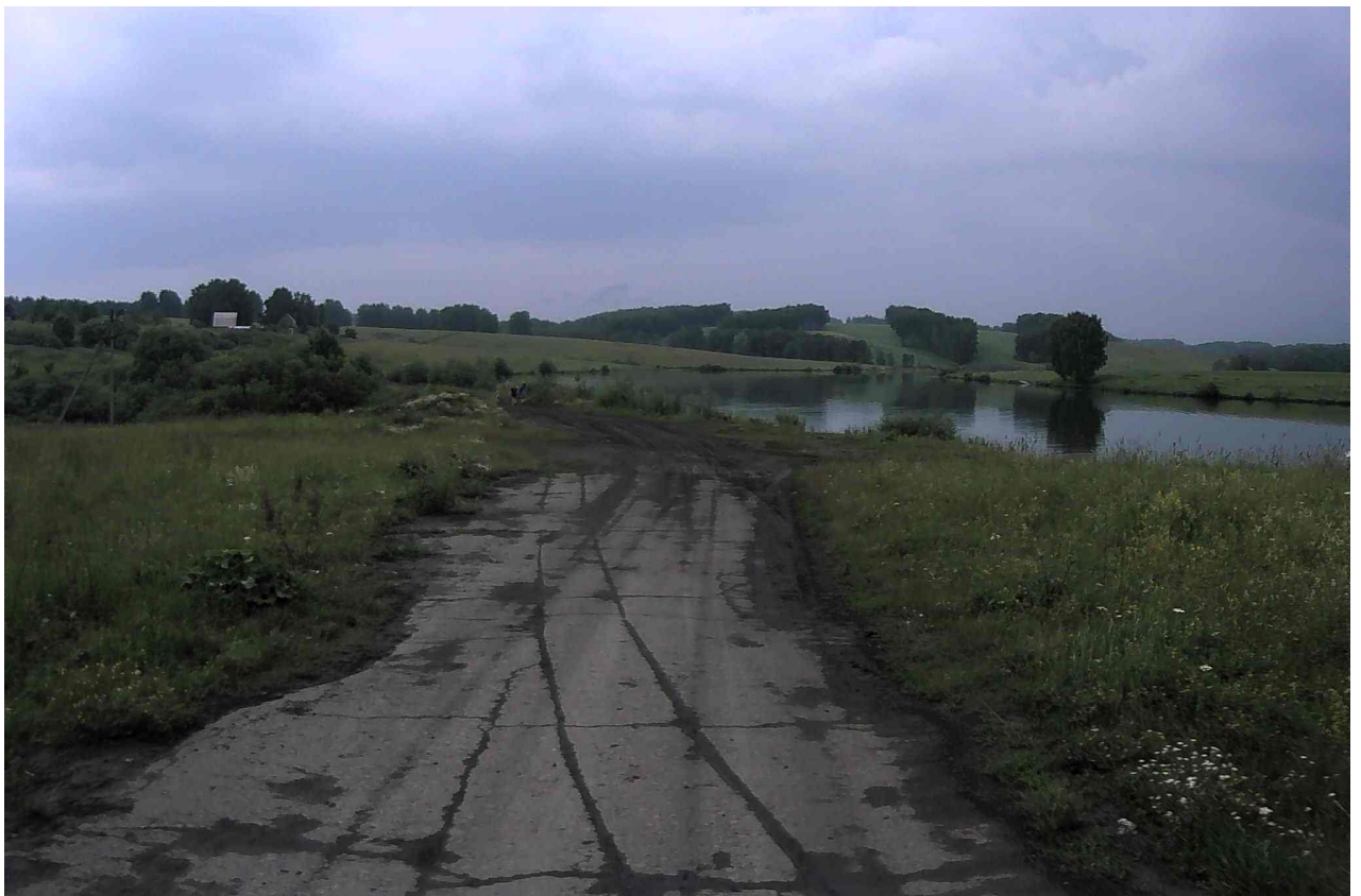
Рисунок 2.1.6 – Состояние покрытия на участке ПК 0+045
