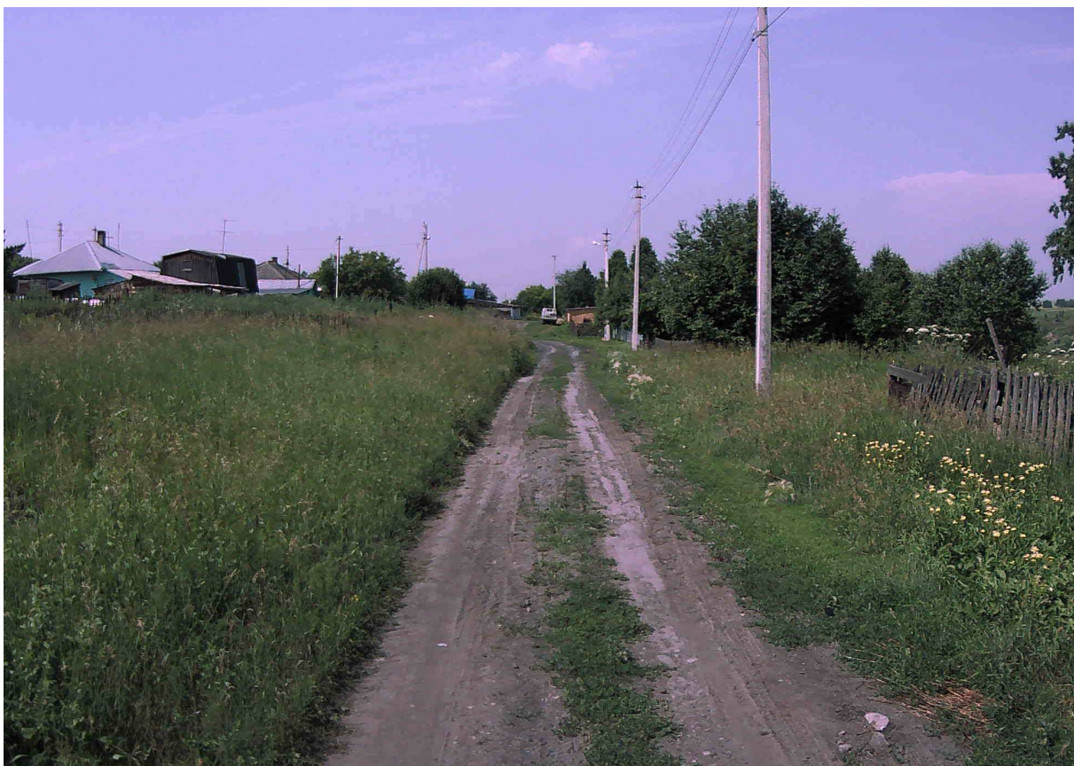
Рисунок 2.9.7 – Состояние покрытия на участке ПК 0+460
