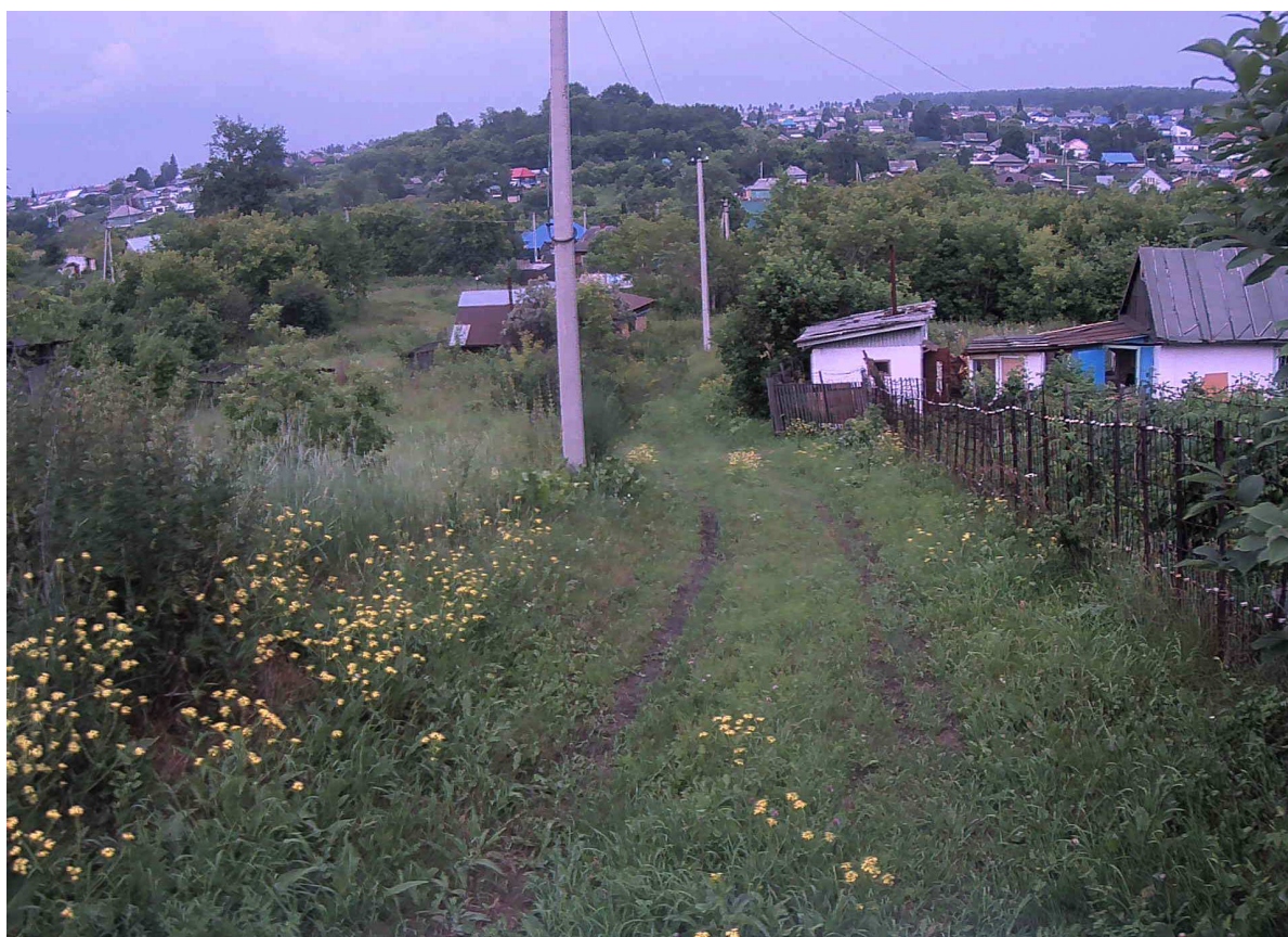
Рисунок 2.8.5 – Состояние покрытия на участке ПК 0+275
