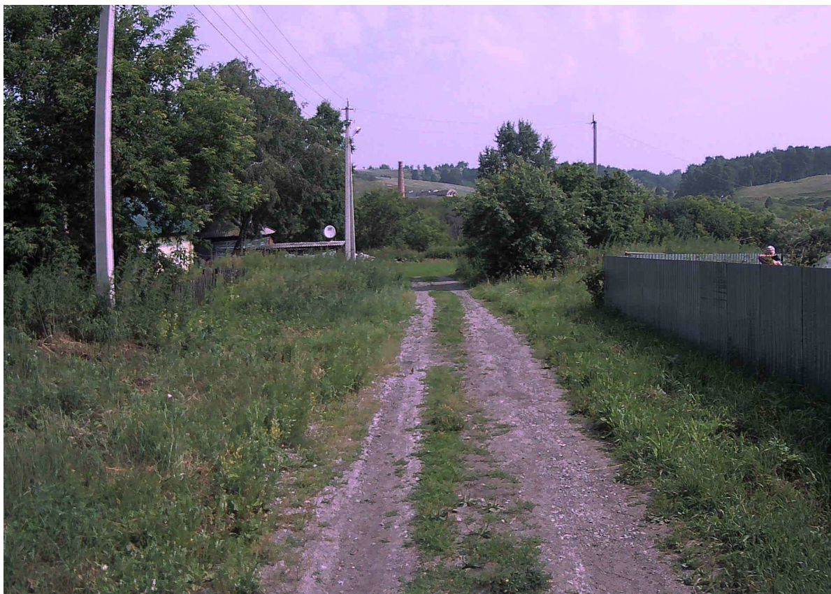
Рисунок 2.11.6 – Состояние покрытия на участке ПК 0+460
