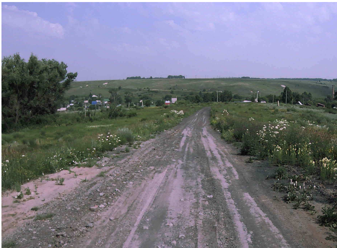
Рисунок 2.11.4 – Состояние покрытия на участке ПК 0+170
