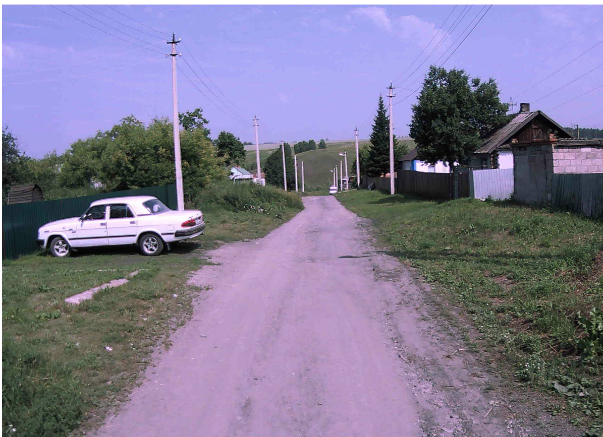
Рисунок 2.14.5 – Состояние покрытия на участке ПК 0+200
