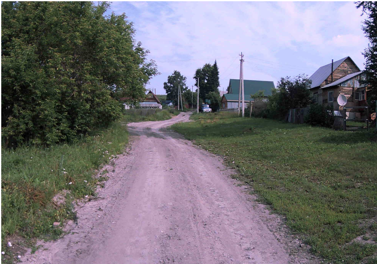
Рисунок 2.3.4 – Состояние покрытия на участке ПК 0+065
