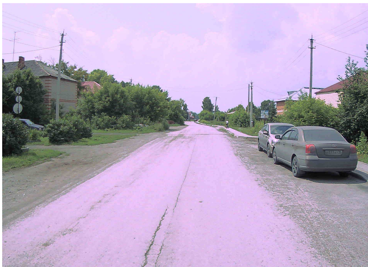
Рисунок 2.24.7 – Состояние покрытия на участке ПК 0+190
