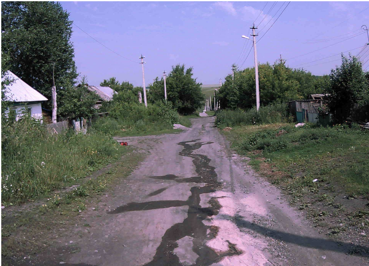
Рисунок 2.14.4 – Состояние покрытия на участке ПК 0+100
