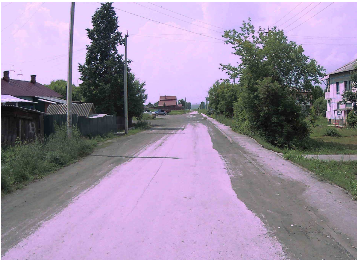
Рисунок 2.24.8 – Состояние покрытия на участке ПК 0+430
