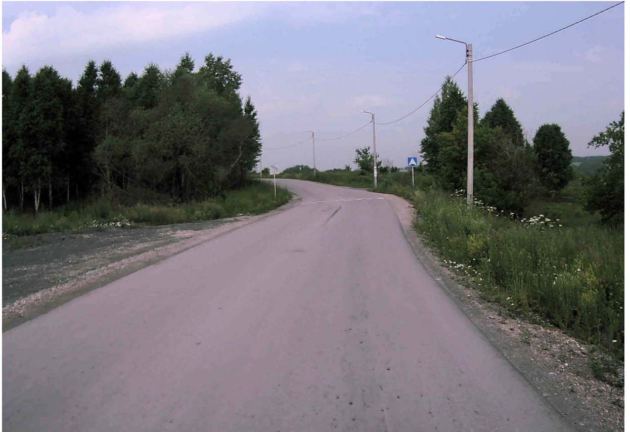
Рисунок 2.17.6 – Состояние покрытия на участке ПК 0+410
