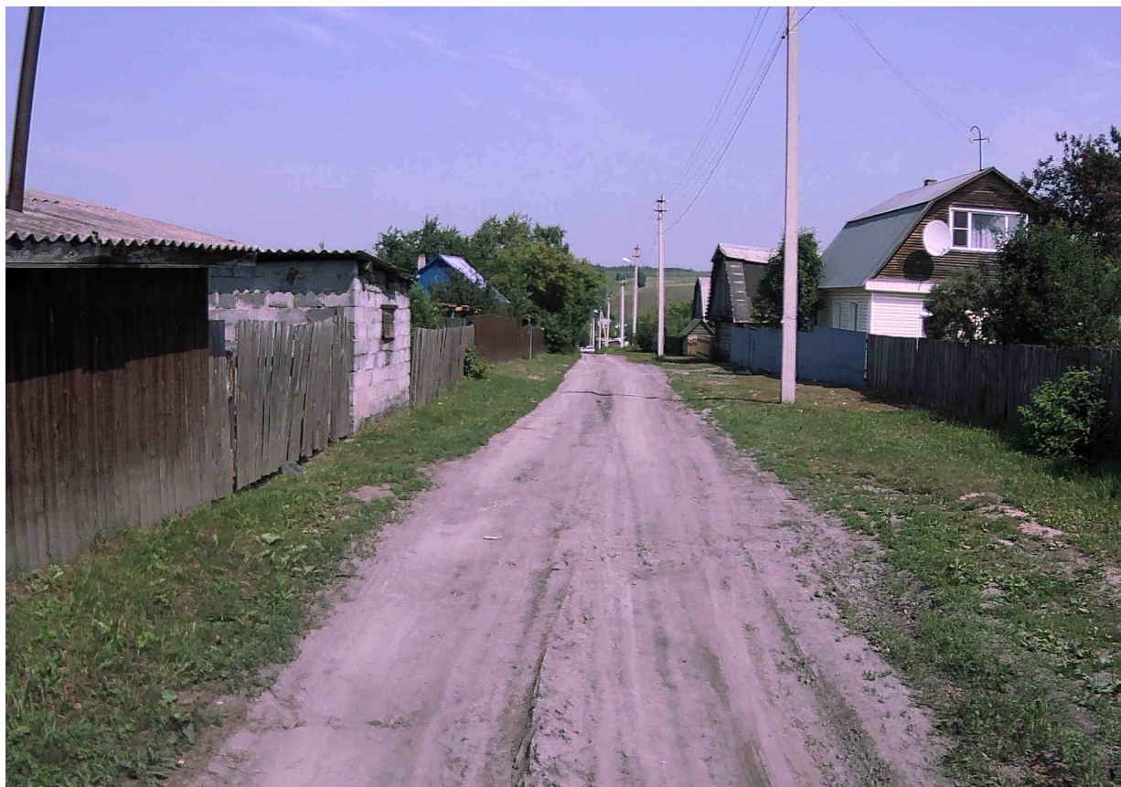
Рисунок 2.15.4 – Состояние покрытия на участке ПК 0+100
