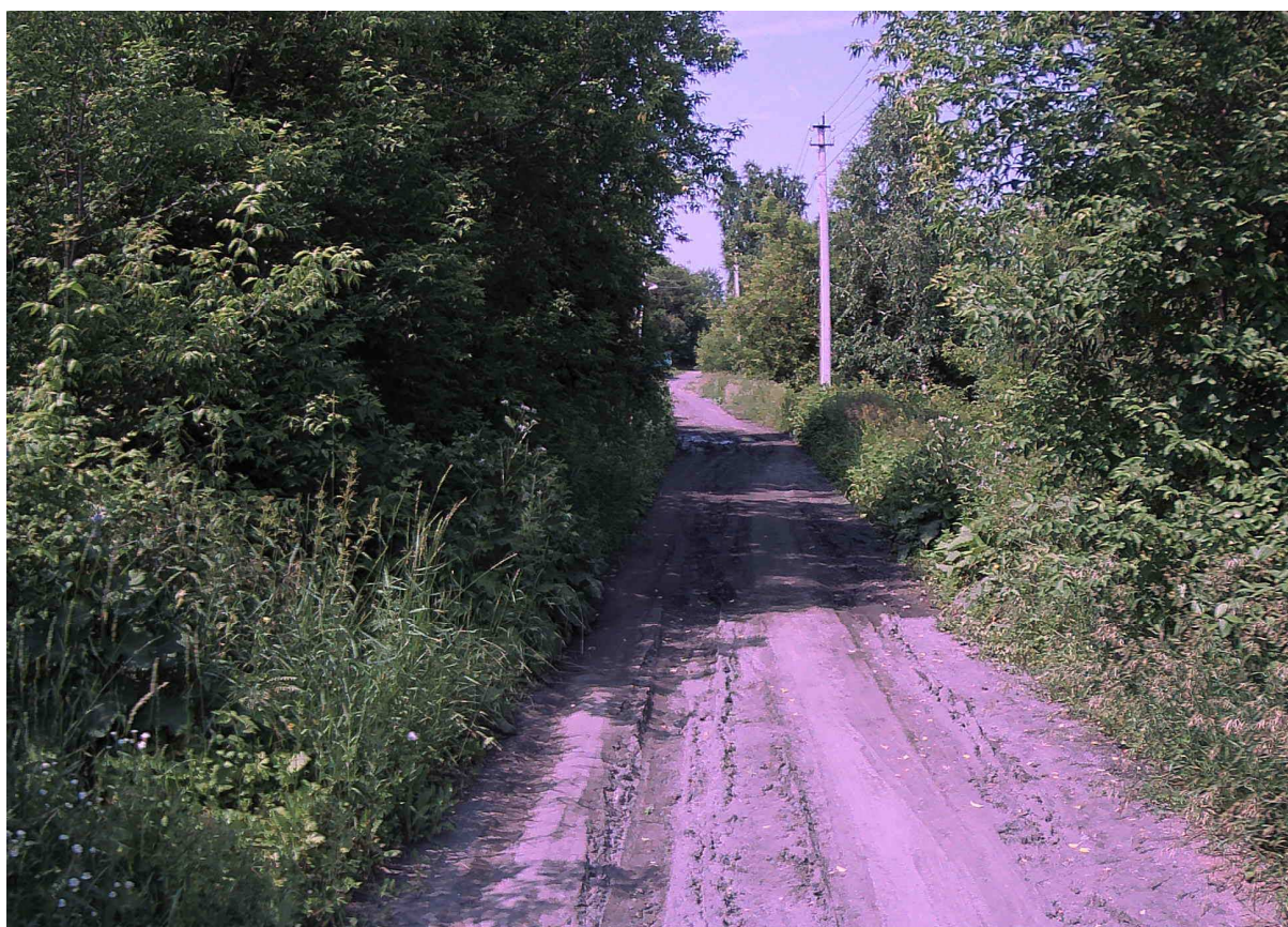
Рисунок 2.9.5 – Состояние покрытия на участке ПК 0+160
