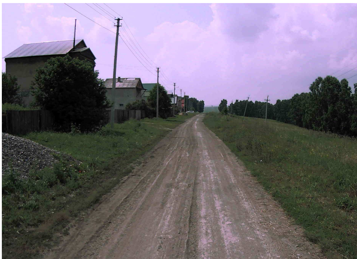
Рисунок 2.24.9 – Состояние покрытия на участке ПК 0+700
