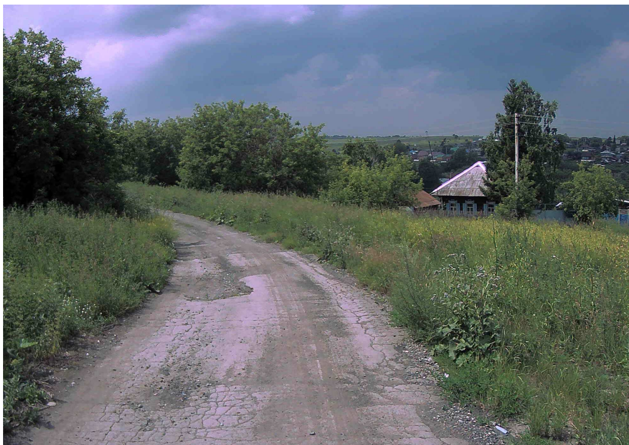
Рисунок 2.22.7 – Состояние покрытия на участке ПК 0+390
