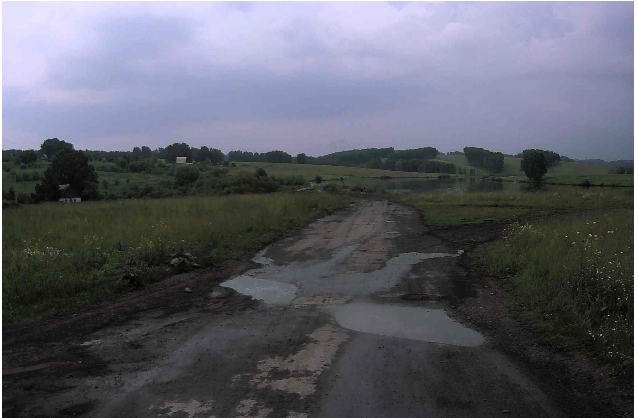
Рисунок 2.1.5 – Состояние покрытия на участке ПК 0+000
