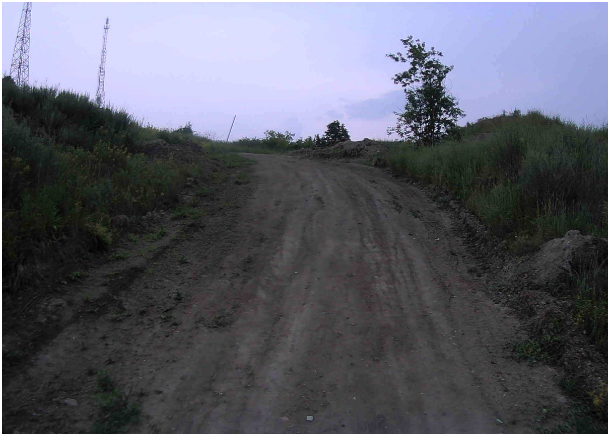
Рисунок 2.8.4 – Состояние покрытия на участке ПК 0+100
