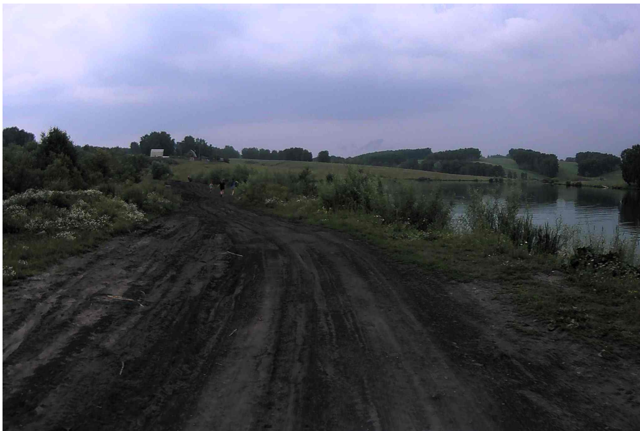
Рисунок 2.1.7 – Состояние покрытия на участке ПК 0+100
