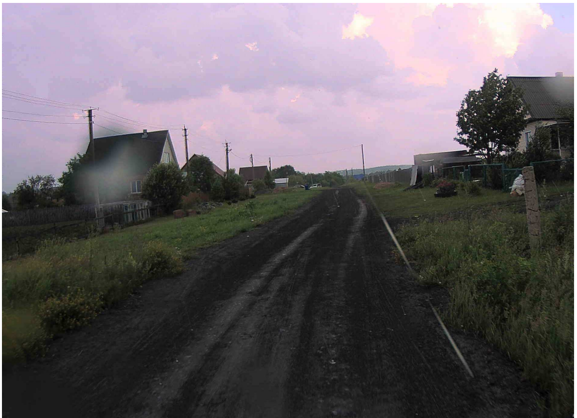
Рисунок 2.13.5 – Состояние покрытия на участке ПК 0+400
