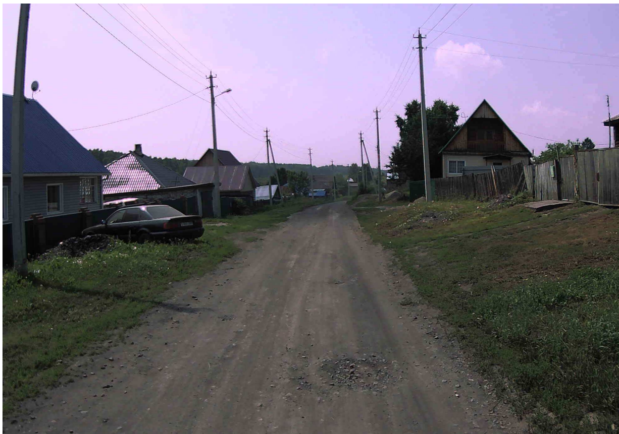
Рисунок 2.10.6 – Состояние покрытия на участке ПК 0+410
