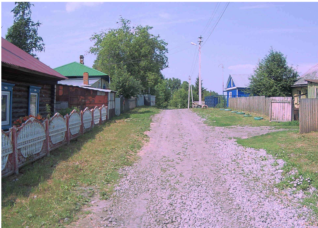
Рисунок 2.9.4 – Состояние покрытия на участке ПК 0+090
