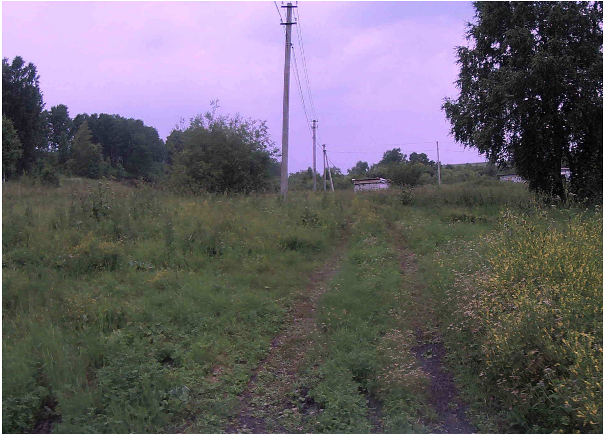
Рисунок 2.20.6 – Состояние покрытия на участке ПК 0+390
