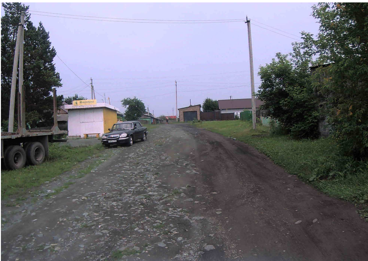
Рисунок 2.18.5 – Состояние покрытия на участке ПК 0+170
