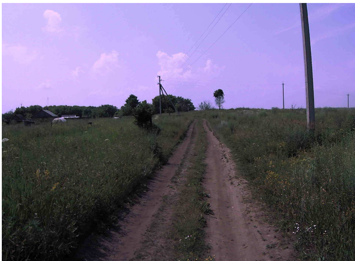
Рисунок 2.16.5 – Состояние покрытия на участке ПК 0+245
