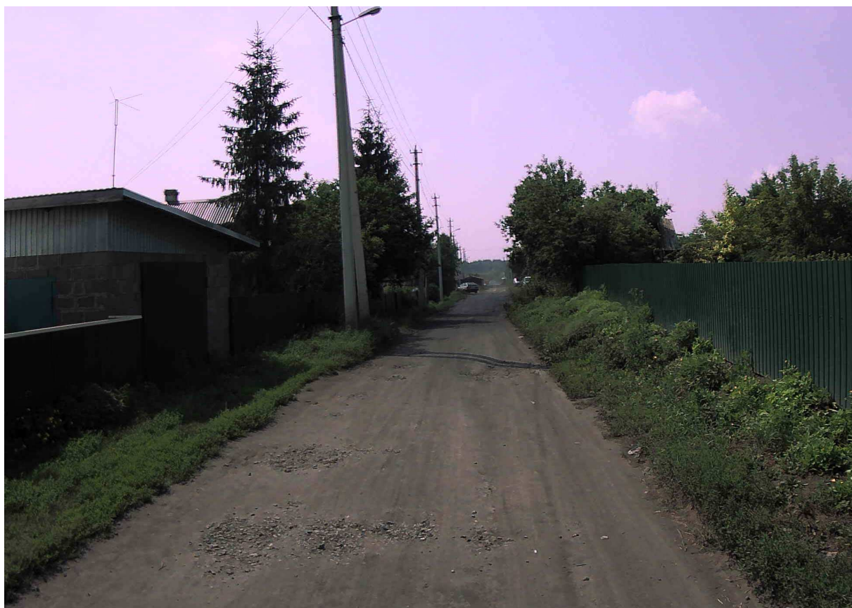
Рисунок 2.10.5 – Состояние покрытия на участке ПК 0+235
