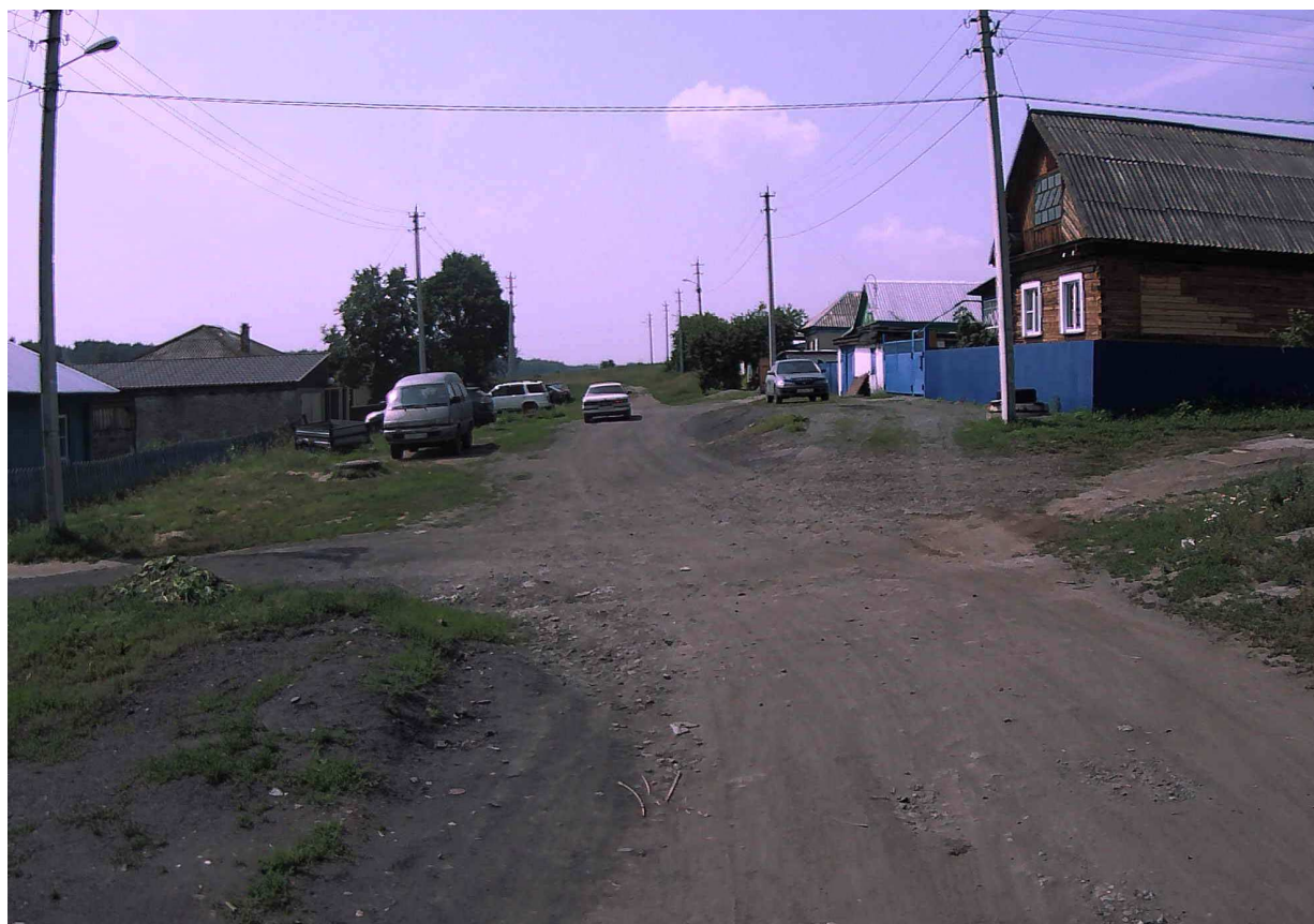
Рисунок 2.10.7 – Состояние покрытия на участке ПК 0+575
