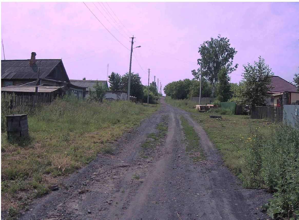
Рисунок 2.23.4 – Состояние покрытия на участке ПК 0+070
