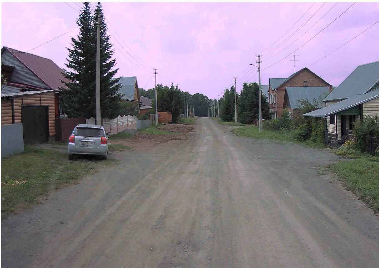
Рисунок 2.12.4 – Состояние покрытия на участке ПК 0+060
