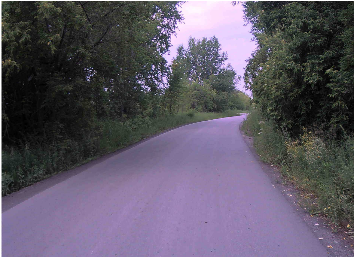
Рисунок 2.17.8 – Состояние покрытия на участке ПК 0+940
