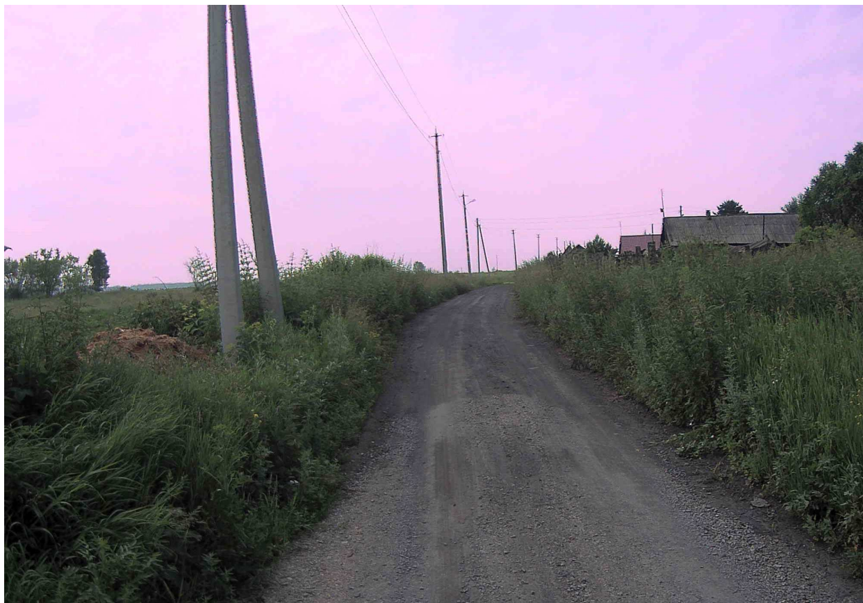
Рисунок 2.21.4 – Состояние покрытия на участке ПК 0+075
