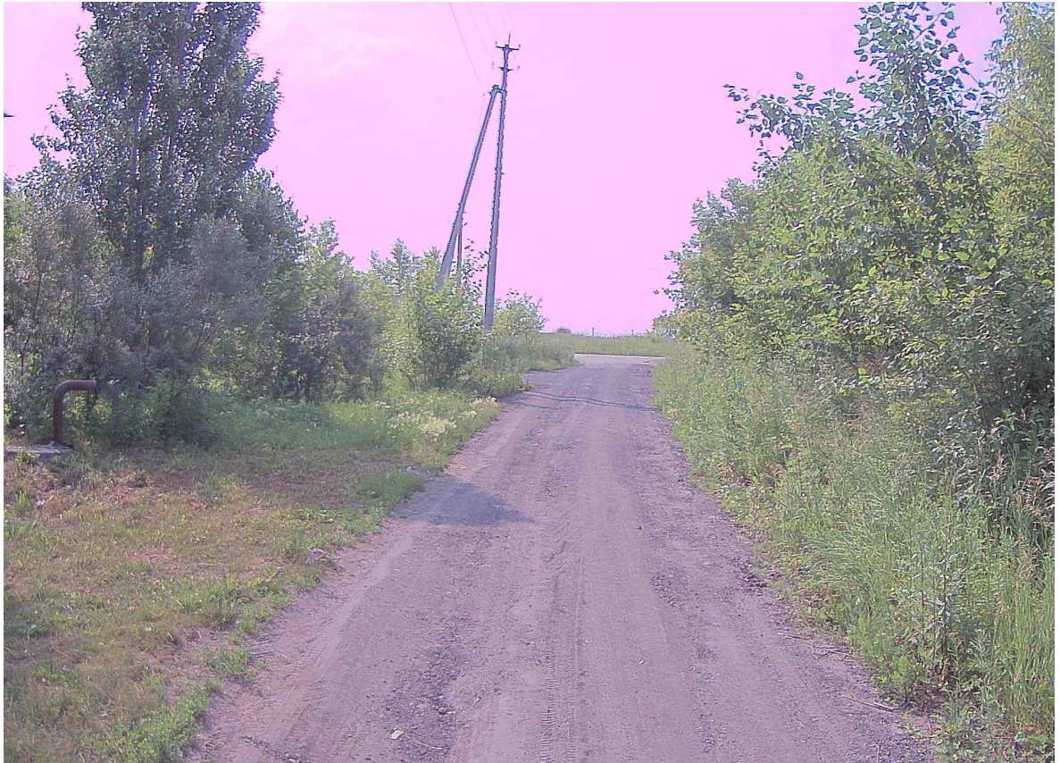
Рисунок 2.23.6 – Состояние покрытия на участке ПК 0+250
