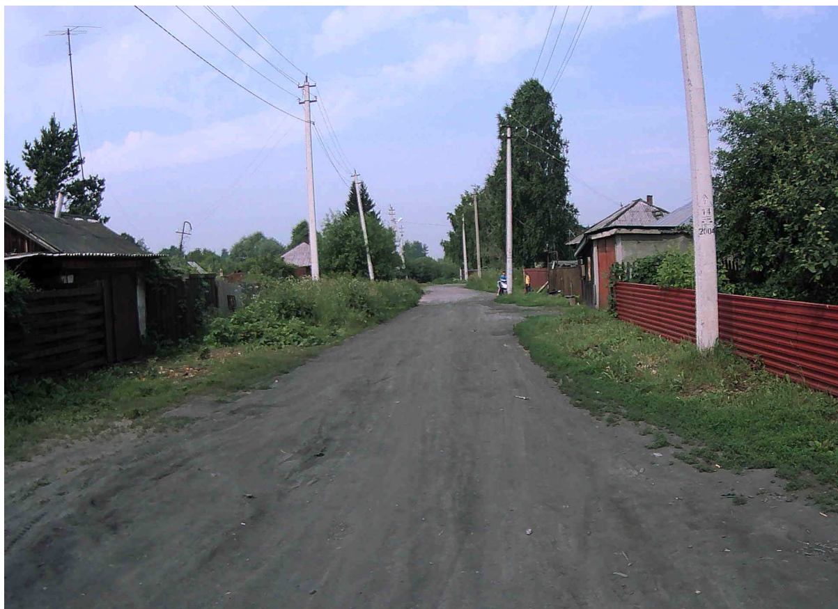
Рисунок 2.19.5 – Состояние покрытия на участке ПК 0+220
