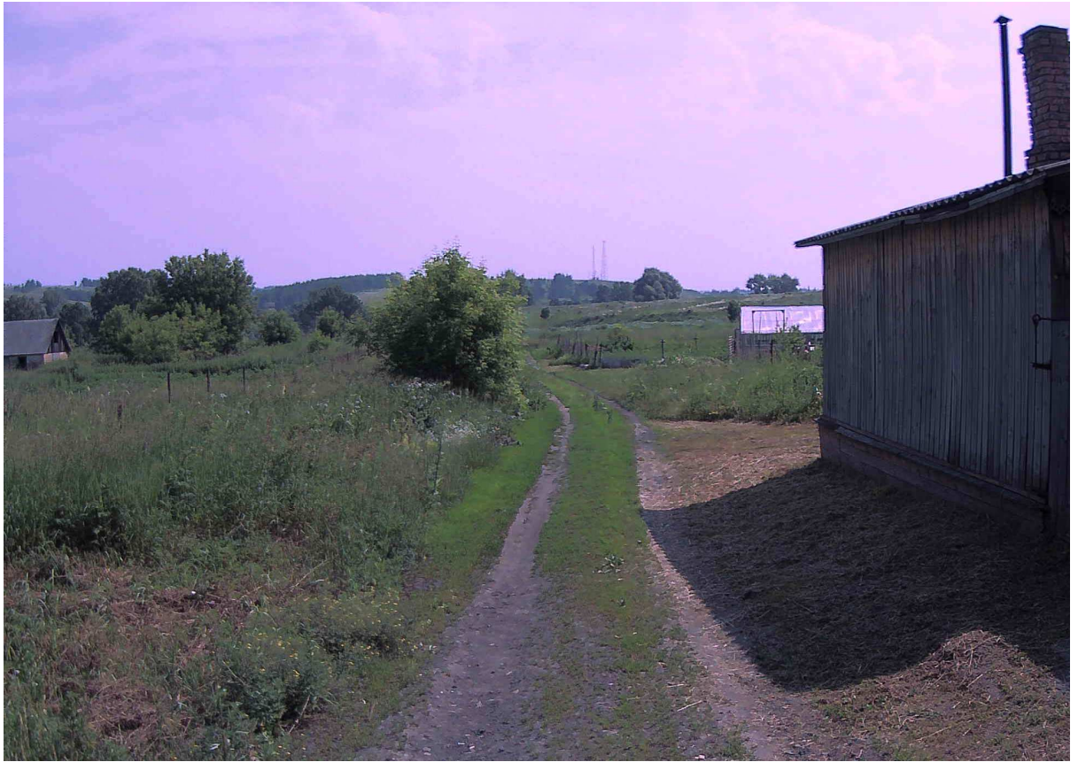
Рисунок 2.6.6 – Состояние покрытия на участке ПК 0+200
