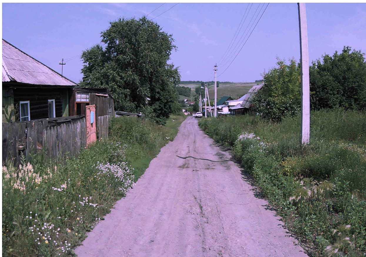
Рисунок 2.15.5 – Состояние покрытия на участке ПК 0+200
