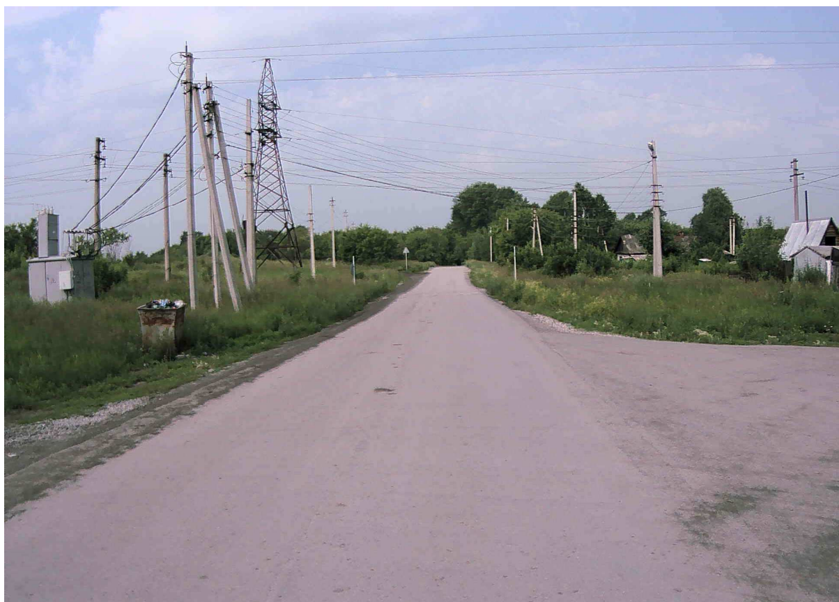
Рисунок 2.17.9 – Состояние покрытия на участке ПК 1+470
