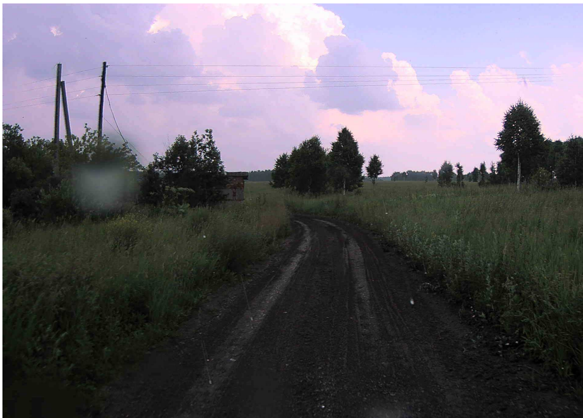
Рисунок 2.13.6 – Состояние покрытия на участке ПК 0+600
