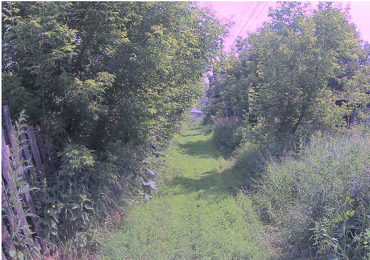
Рисунок 2.6.4 – Состояние покрытия на участке ПК 0+055
