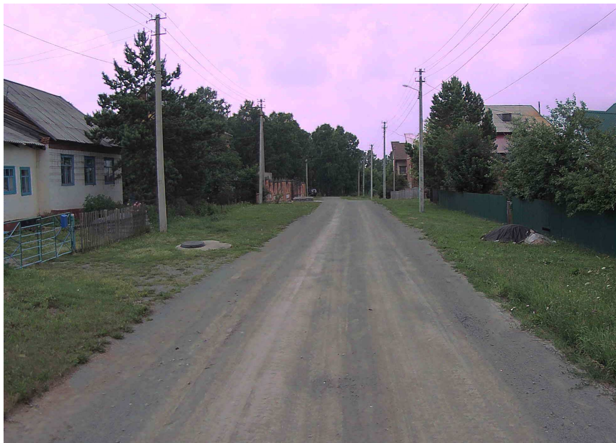
Рисунок 2.12.5 – Состояние покрытия на участке ПК 0+185
